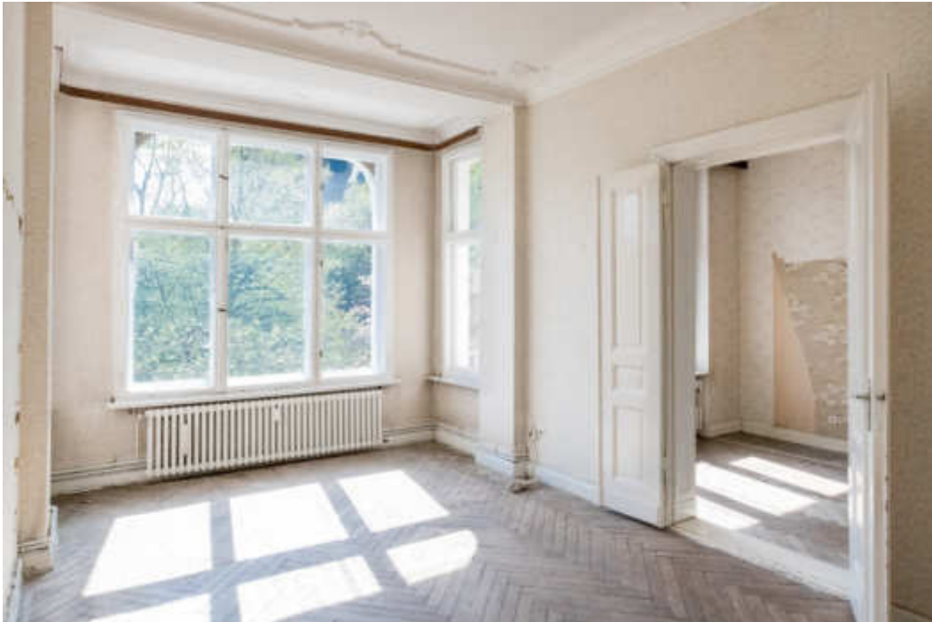
Wohnzimmer (vor Sanierung)
