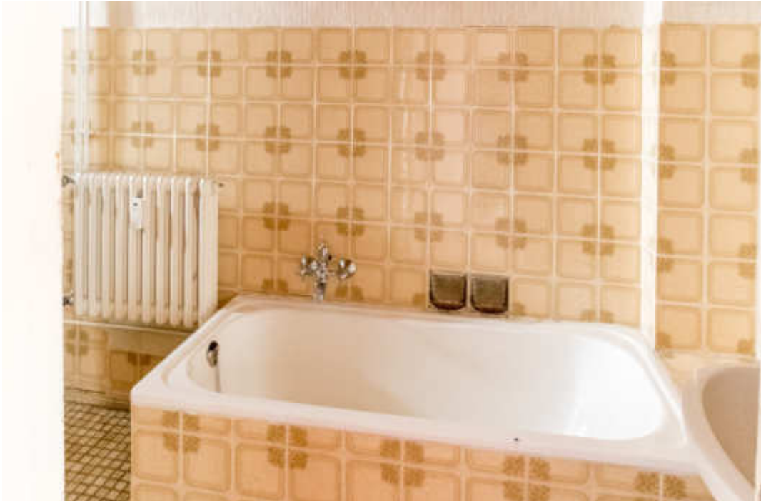
Bad (vor Sanierung)
