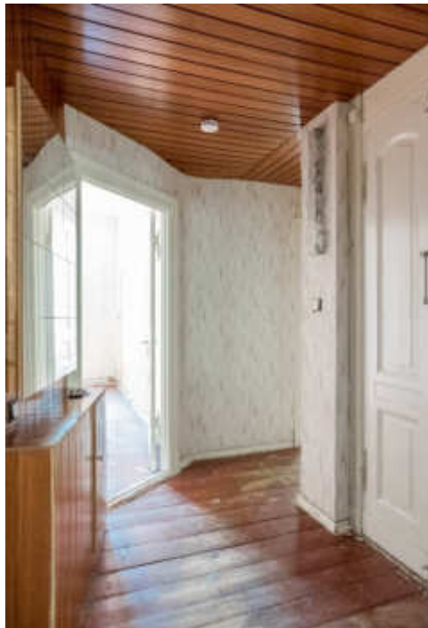
Flur (vor Sanierung)
