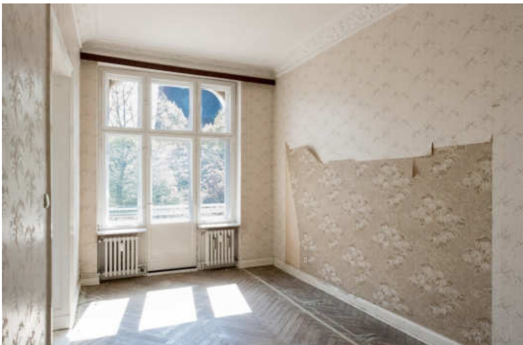
Schlafen 1 (vor Sanierung)
